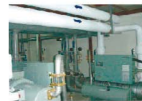
Машинный зал для chillера внутреннего монтажа
